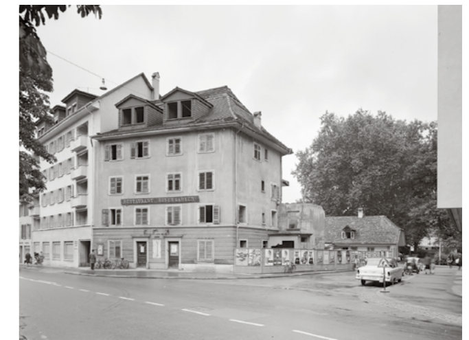
09/010 Abbruch des ehemaligen Restaurants Rosengarten ab 1962
