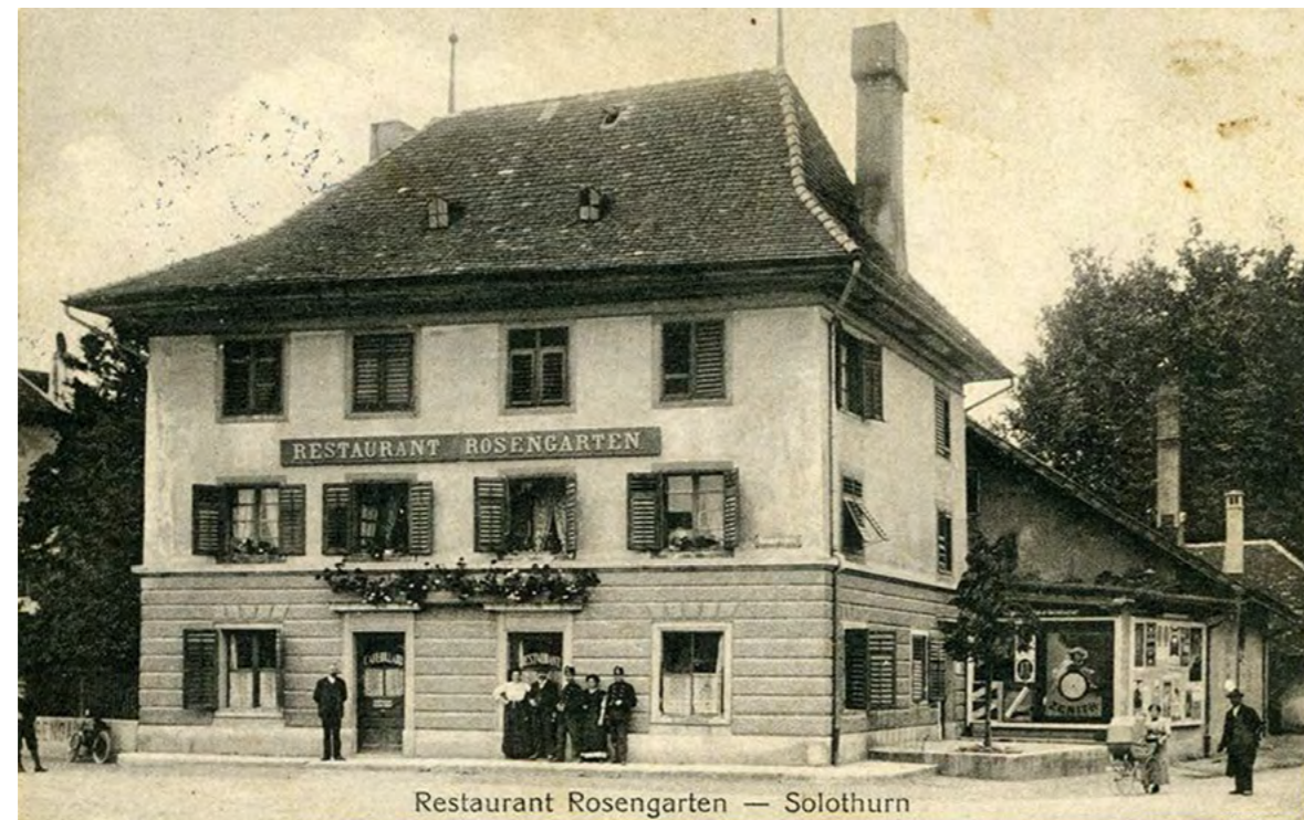
06 Südansicht des Restaurants Rosengarten, 1915 (Poststempel)
