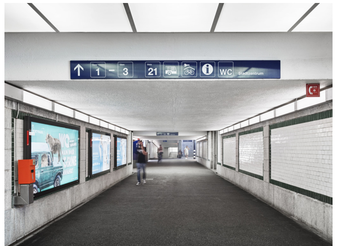
Personenunterführung | Bahnhof Solothurn
