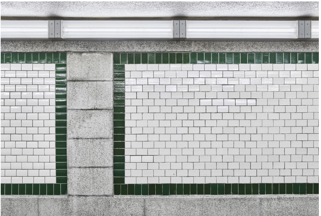
Sanierte Plattenfelder | Bahnhof Solothurn
