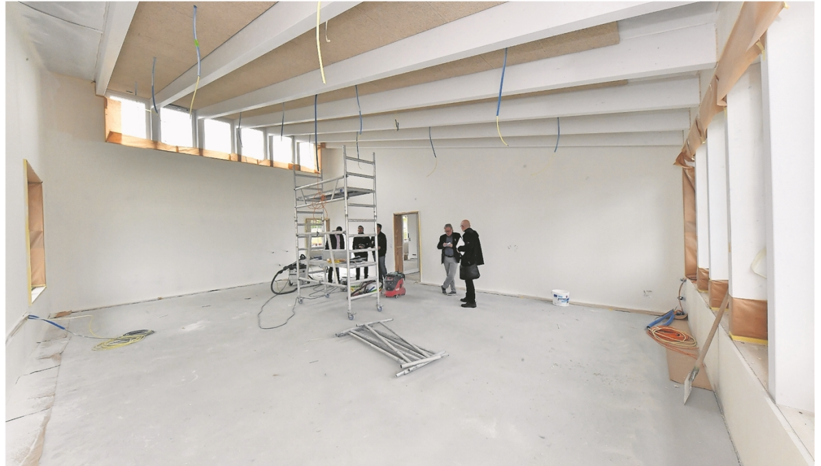
Klassenraum im Obergeschoss: 75 Quadratmeter gross, die Decke mit sogenannten «Spaghetti-Platten» ausgestaltet.
