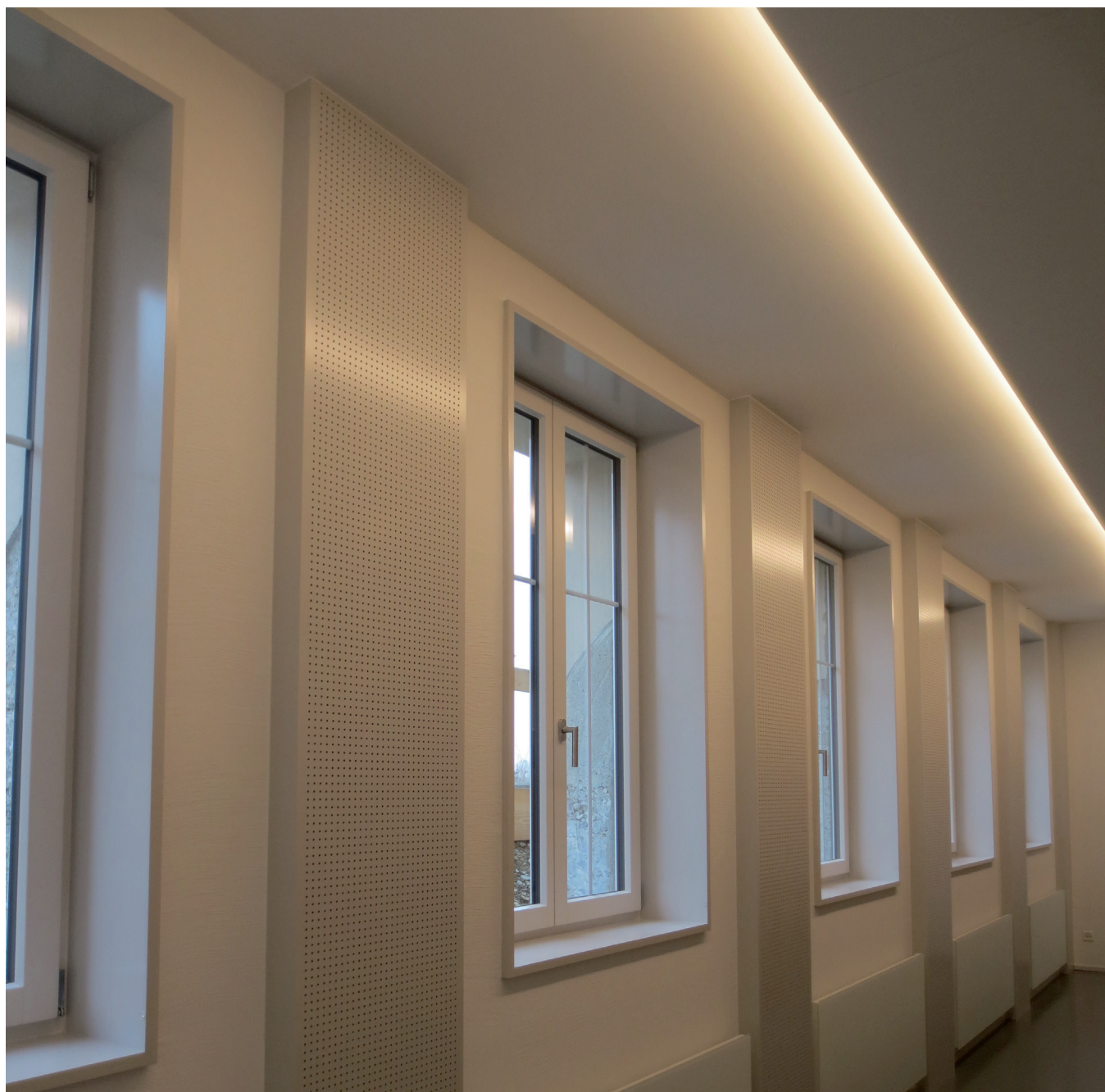
Säali - neue Fenster mit tieferen Brüstungen und umlaufendem Futter, Akustik-elemente, Voutenbeleuchtung
