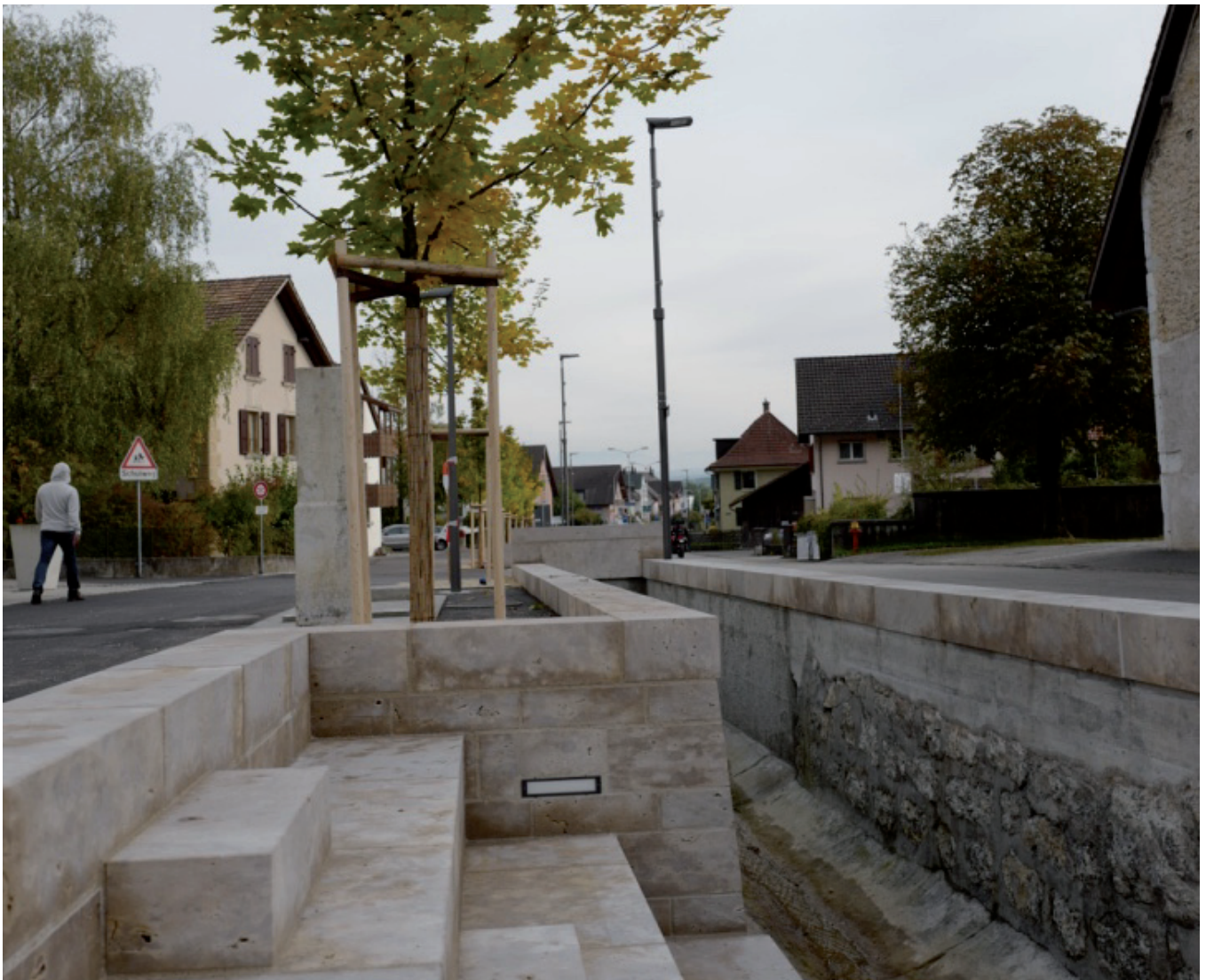
Mauerkrone und Sitzstufen Naturstein Dietfurter Dolomit
